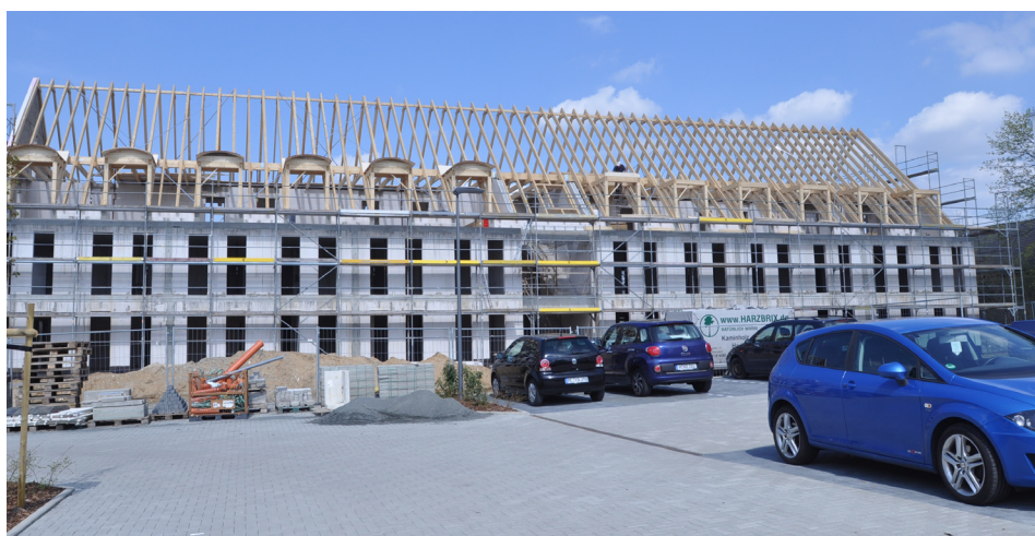
Auf dem Platz der ehemaligen Panzerhalle (Am Exer 43) entsteht derzeit das dritte Haus im neuen Studentenwohnheim-Ensemble im Südosten des Exer. Mitte April war Richtfest.
