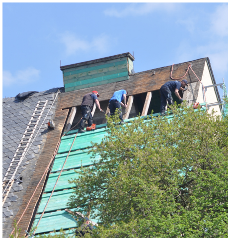
Das Dach des Hauses Am Exer 10 wird mit neuen Schieferplatten bedeckt. Damit sind die Dachsanierungen des tiw vorerst abgeschlossen.
