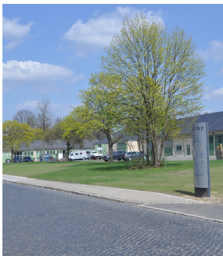
Von der ehemaligen Militär-Tankstelle ist nichts mehr zu sehen. An ihrem Standort wurde die Rasenfläche erweitert. Nur wenige Meter entfernt steht jetzt die neue E-Ladesäule.
