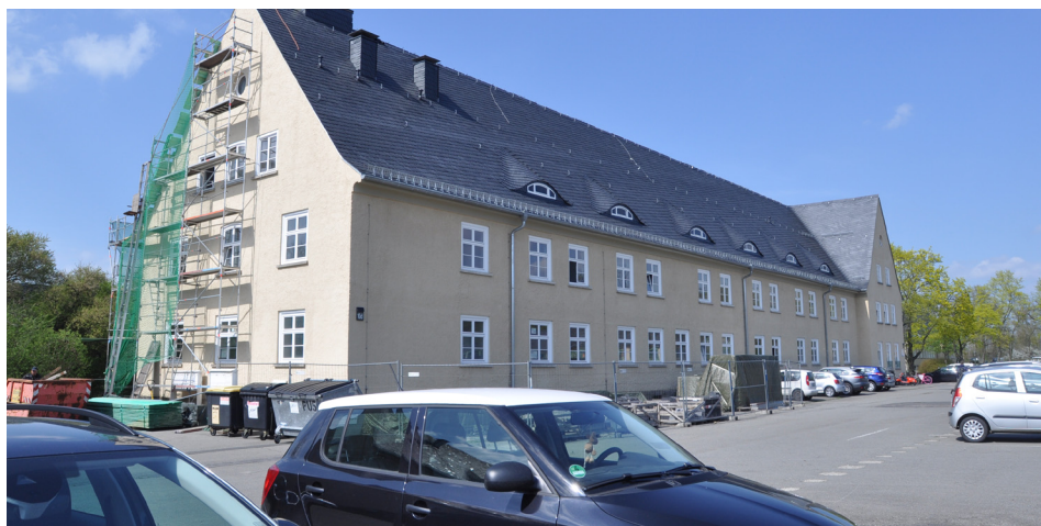
Das Dach des Hauses Am Exer 10 wird mit neuen Schieferplatten bedeckt. Damit sind die Dachsanierungen des tiw vorerst abgeschlossen.
