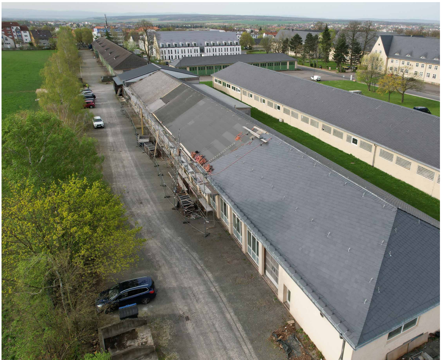
Auf der Halle AE29 werden gerade die letzten Meter Schiefer verlegt.
