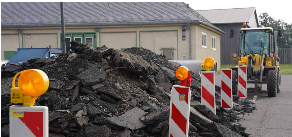
In einem ersten Arbeitsschritt wurde die Asphaltsschicht abgefräst.
