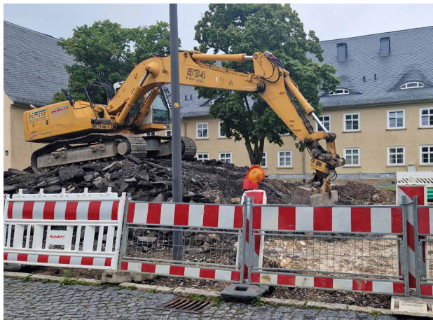
Mächtige Erdmassen werden derzeit Am Exer bewegt. Die Regenwasser-Kanalisation stammt noch aus dem Baujahr der ehemaligen Kaserne (1936) und muss dringend saniert werden. Foto: Regio-Press
